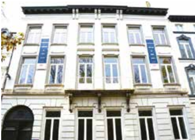
» Gevel voormalige woning Charles Drybergh: Léon Spilliaertstraat 21
