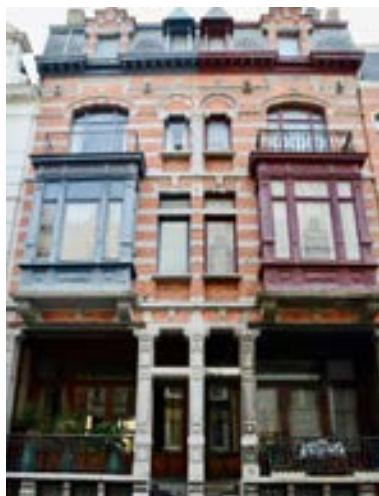
» Gevel Brusselstraat 20 (links) © Valère Prinzie
